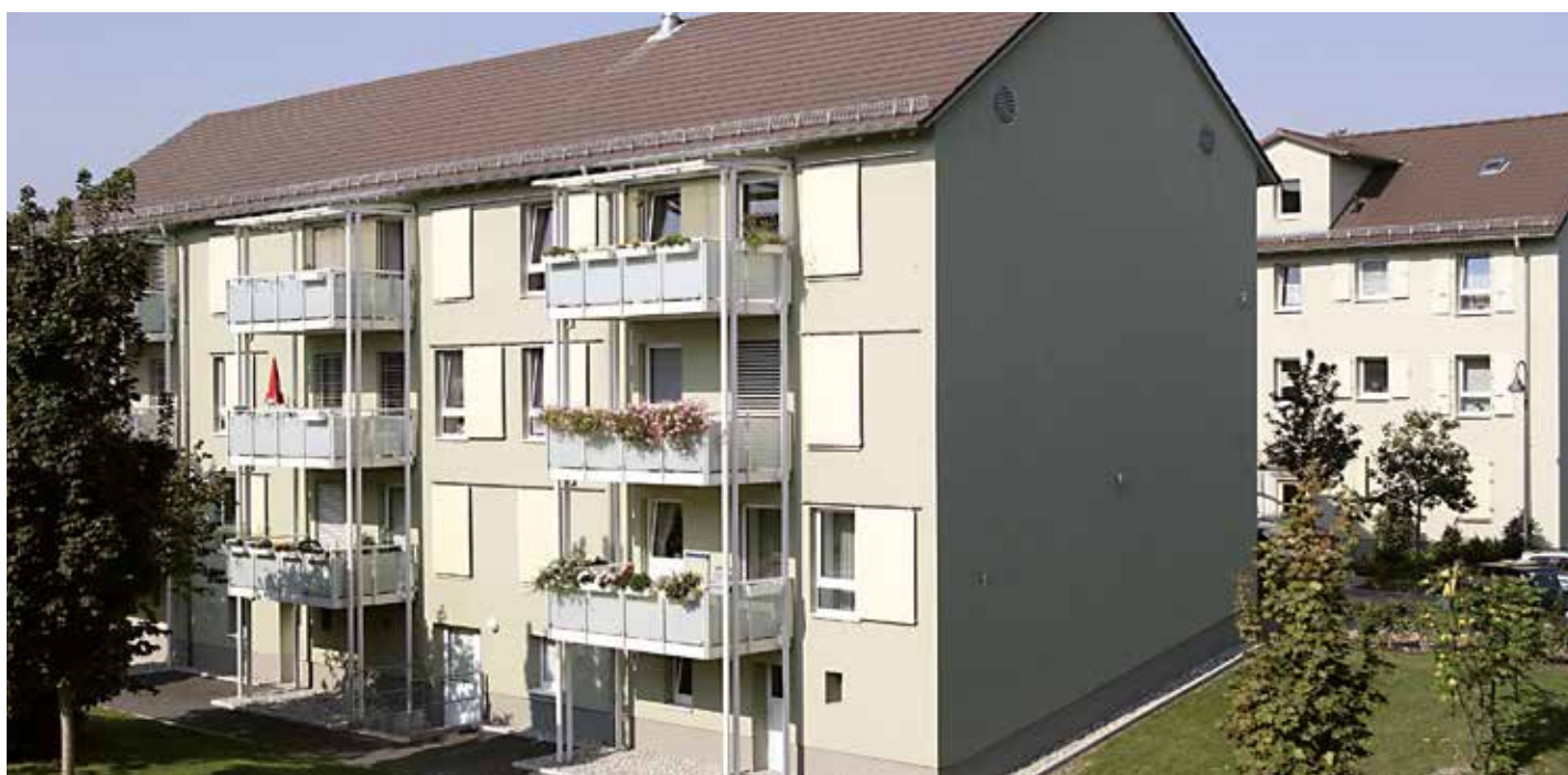
Quartiere Brunck. Case 3 litri dopo la ristrutturazione
