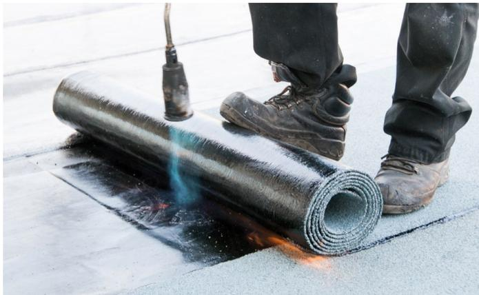
Auf den Gefälleelementen wurde als spezielle Trennlage eine Kaltklebbahn verlegt. Hierauf wurden die Bitumenbahnen geschweißt.
