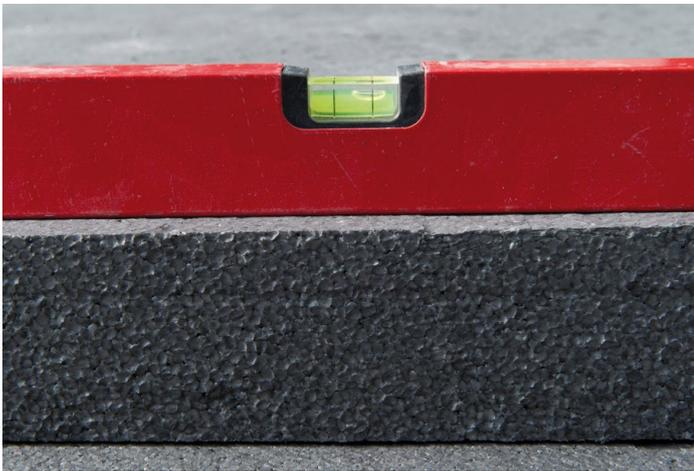
Im zweiten Arbeitsgang wurden die leichten aber sehr tragfähigen Gefälleelemente aus Neopor® auf den Flachdachdämmplatten aus Neopor® verlegt und befestigt. Die Gefälleelemente ersparen den schweren Gefällebeton. Die Oberflächenwasserableitung lässt sich mit Gefälleelementen präzise planen und ausführen.
